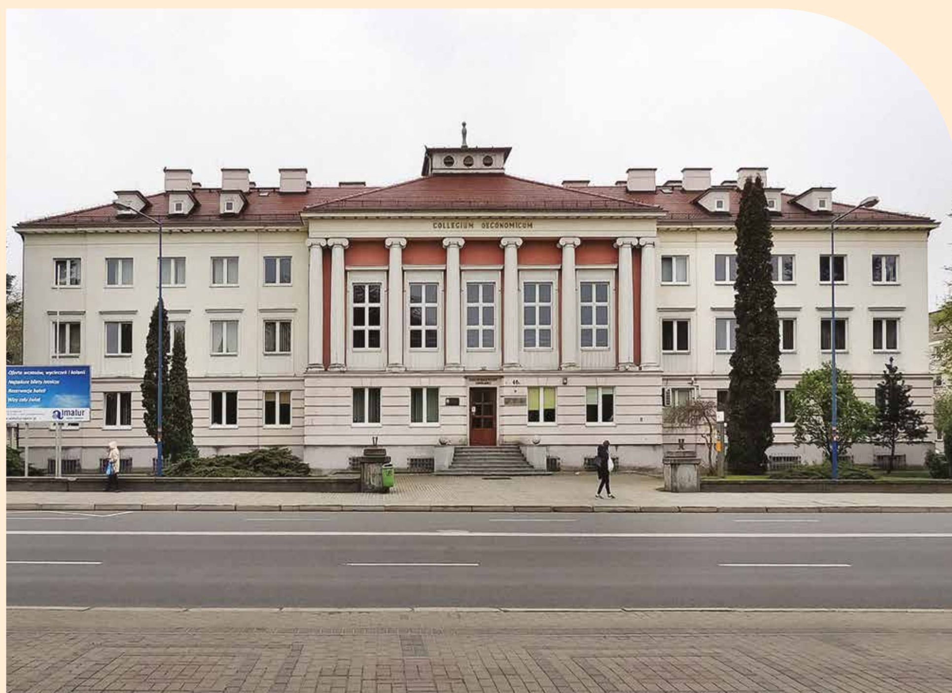
Przekazanie budynku dawnego KW PZPR przy ul. Ozimskiej Instytutowi Nauk Ekonomicznych UO.
