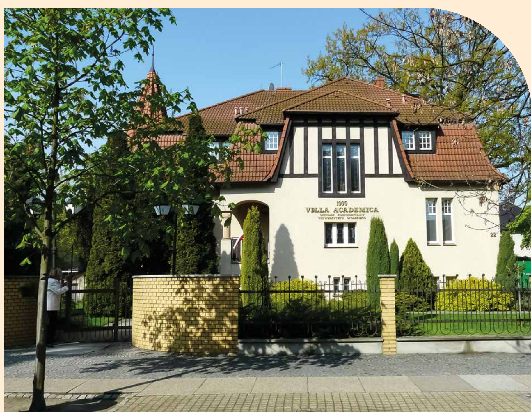
Villa Academica, Ośrodek Konferencyjny Uniwersytetu Opolskiego, gruntownie odrestaurowana po zniszczeniach spowodowanych powodzią.
