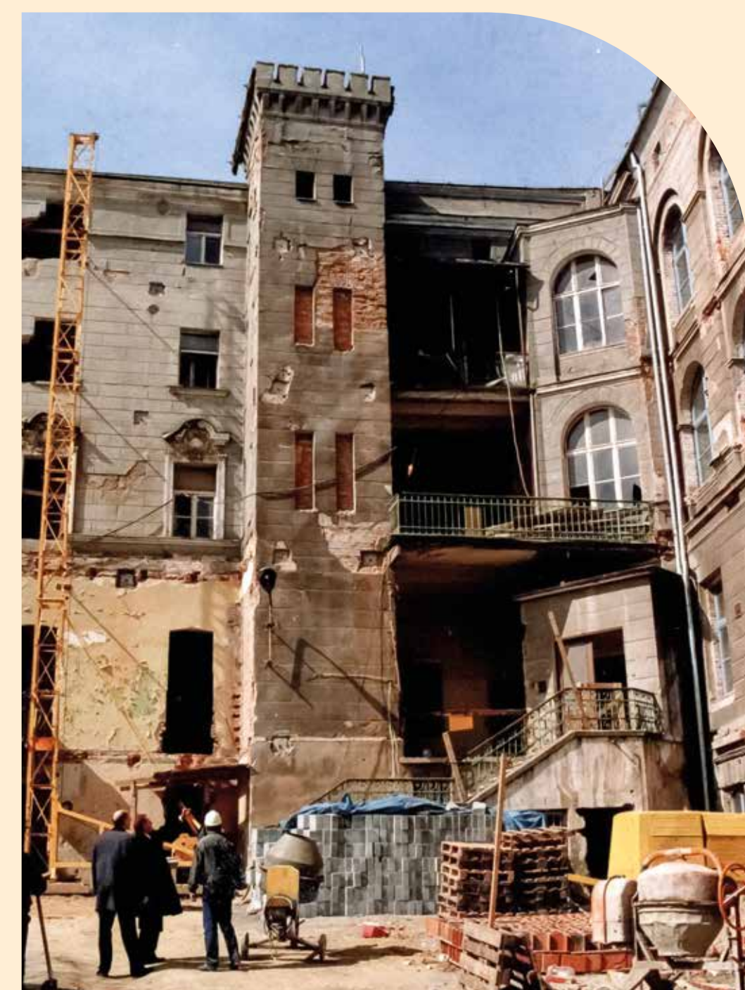
Rozbiórka dawnego szpitala przy pl. Kopernika pod budowę gmachu Collegium Maius.
