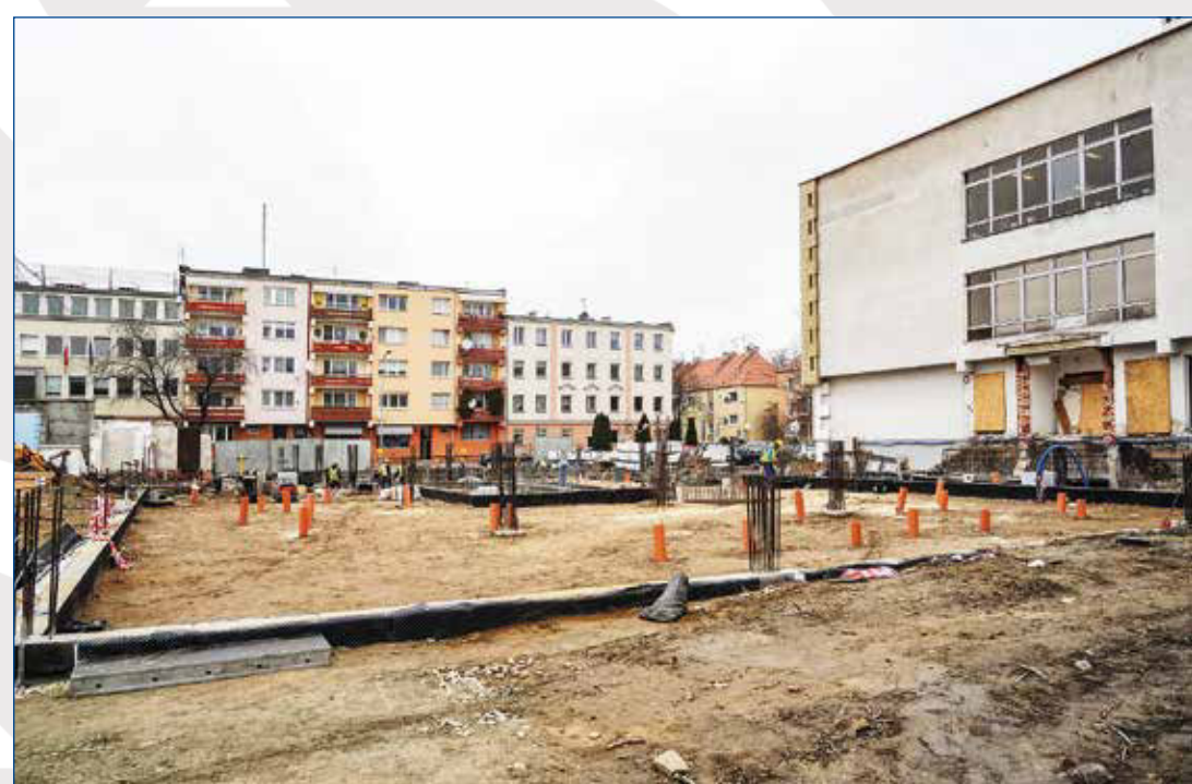
Plac budowy centrum badawczo-rozwojowego Pomologia przy ulicy Oleskiej w Opolu
