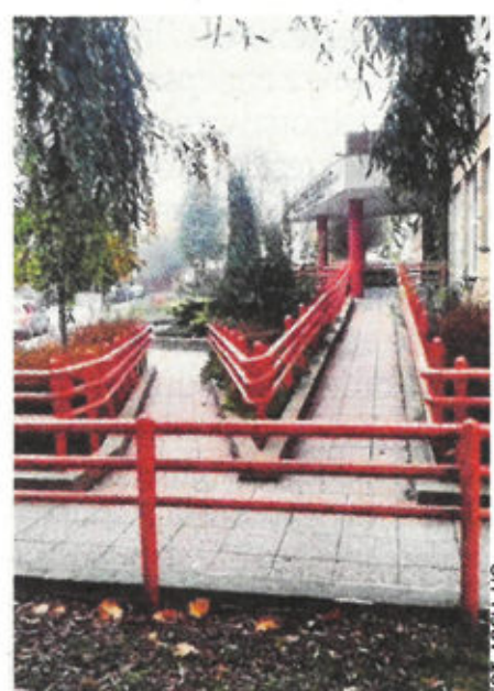
Podjazd dla wózków do Collegium Civitas UO.
